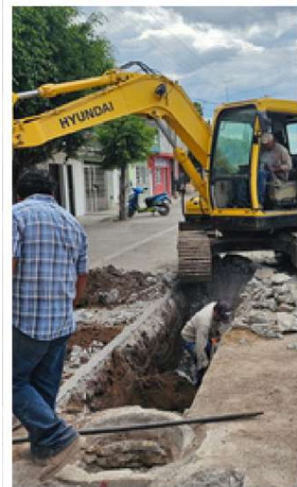
Rehabilitación de drenaje sanitario en calle Verástegui en calle San Miguel a calle Insurgentes.
