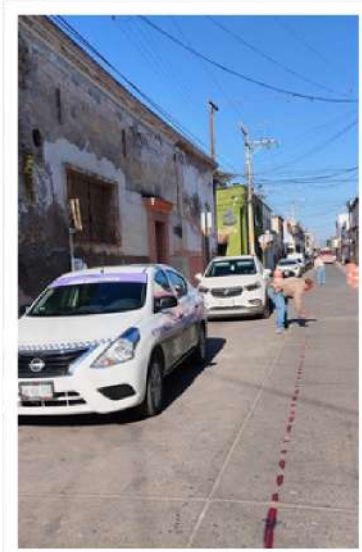
Rehabilitación de drenaje sanitario en calle Gallardo de calle Madero a calle Hidalgo.
