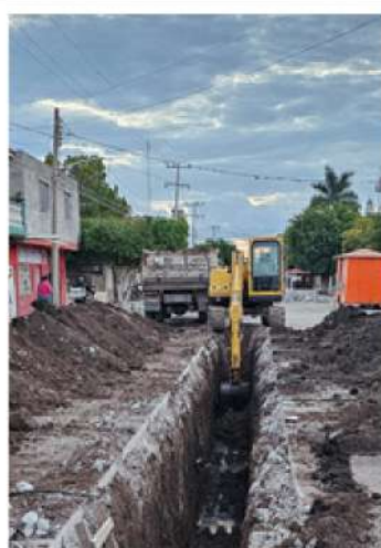
Rehabilitación de drenaje sanitario en calle Verástegui en calle San Miguel a calle Insurgentes.
