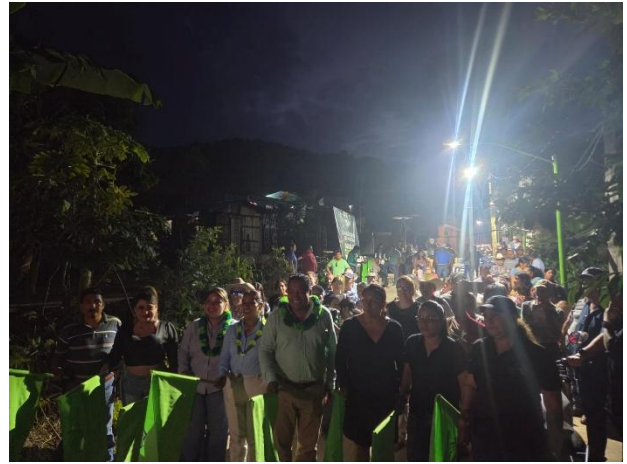
Arranque Construcción de Puente Vehicular Aguazarca
