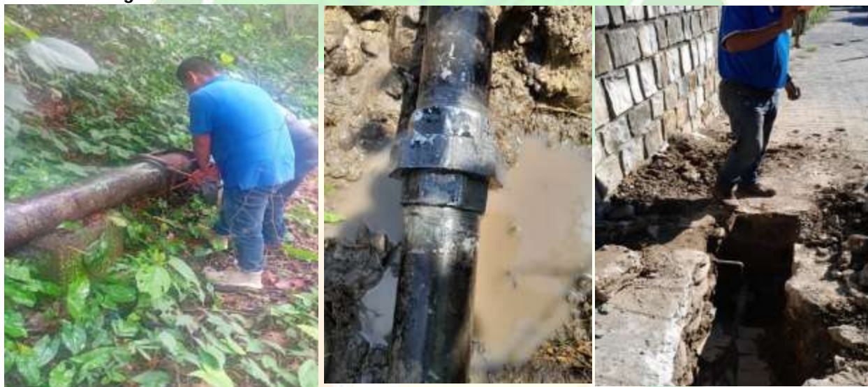
(Ilustraciones.- Arreglo de fuga
