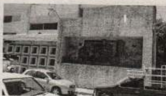
Fotografía No.15 Biblioteca Municipal. Consultor.2015.
