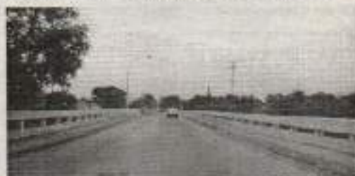
Imagen 26. Puente Zacatipán, Carretera federal No. 102, Consultor.
