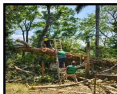
SE ATENDIÓ REPORTE DE UN ÁRBOL CAÍDO, EN LA LOCALIDAD DE AHUACATITLA.
