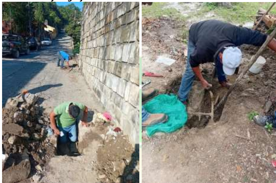
(Reparación de fugas en la línea de conducción)
