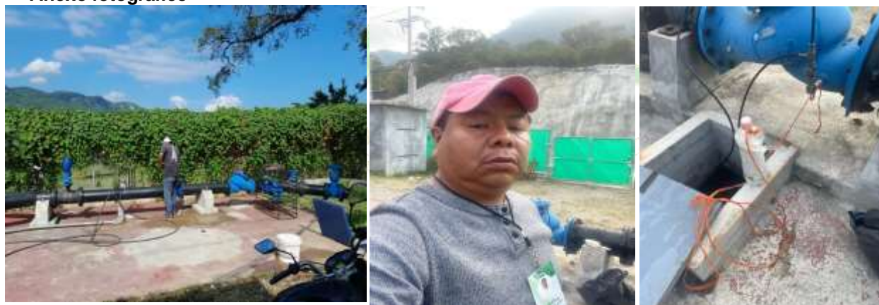
(Limpieza y mantenimiento de los tinacos de almacenamiento de agua potable)
