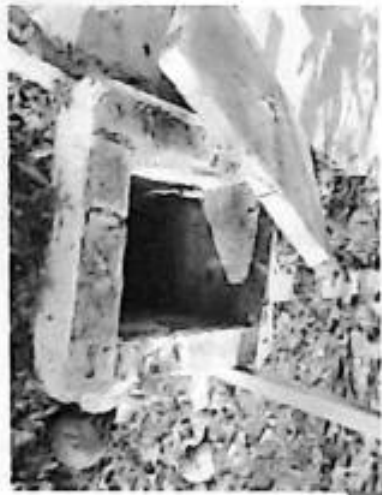
Esc. Prim. T/M. "Niños Héroes" Verificación eléctrica La Celba Tenexcalco
