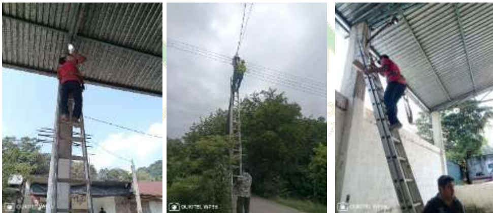
(Ilustraciones.- cambio de focos y fotoceldas).
