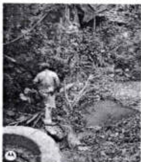
Retiro de basura, chapoleo Y recolección de la misma en arroyo Tenango altura calle 5 de mayo.
