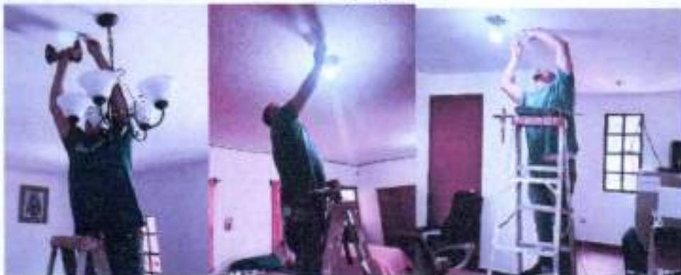
Instalación de 32 detectores de humo 28/07/25
