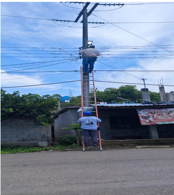
ENRAMADITAS ARREGLO DE LUMINARIAS
