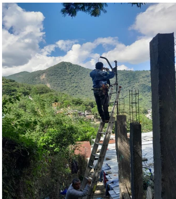
CALLEJON COHETERIA INSTALACION DE LUMINARIAS DE MEDIO USO
