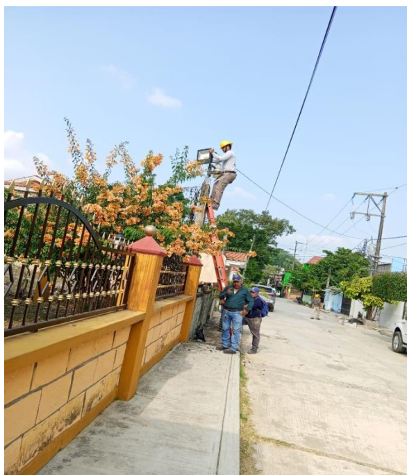
PRESTAMO E INSTALACION DE REFLECTORES FRACC. BUENOS AIRES
