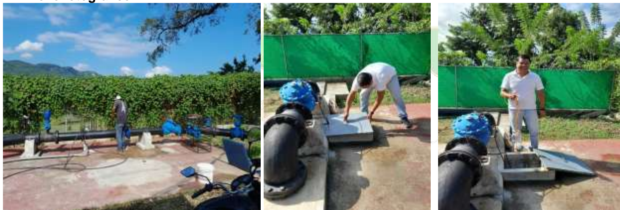
(Limpieza y mantenimiento de los tinacos de almacenamiento de agua potable)
