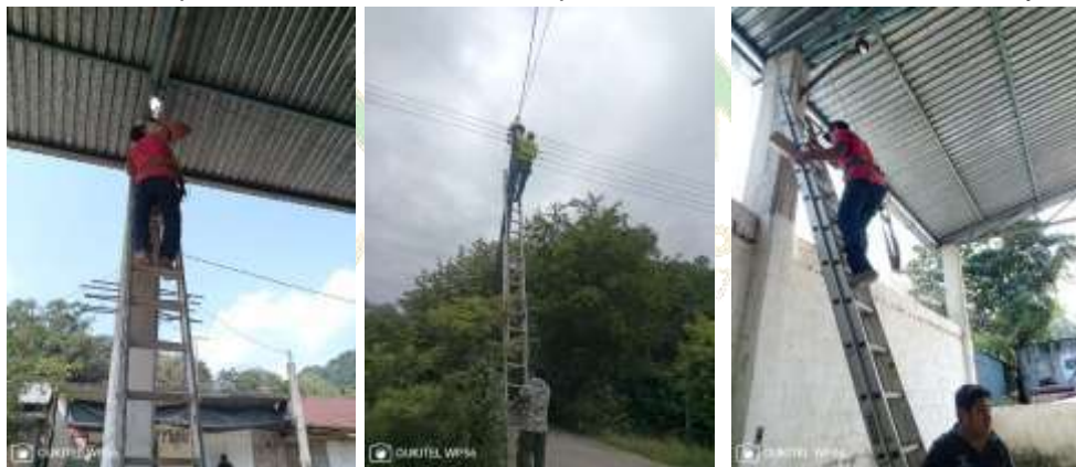
(Ilustraciones.- cambio de focos y fotoceldas).
