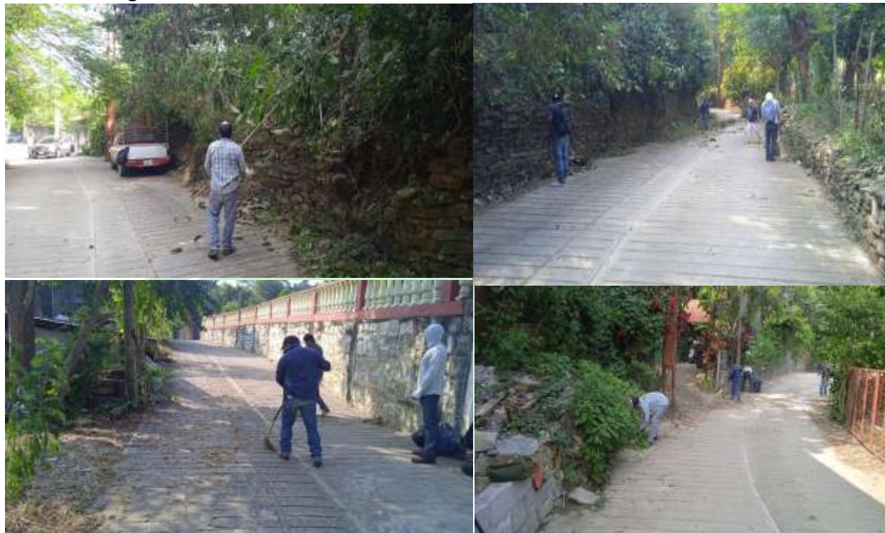
(Ilustración.- mantenimiento a caminos y carreteras del municipio de Tancanhuitz).
