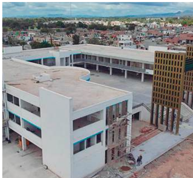
Avanza la construcción de la nueva Unidad Administrativa Municipal, con un progreso del 85% para dignificar la atención al usuario.
