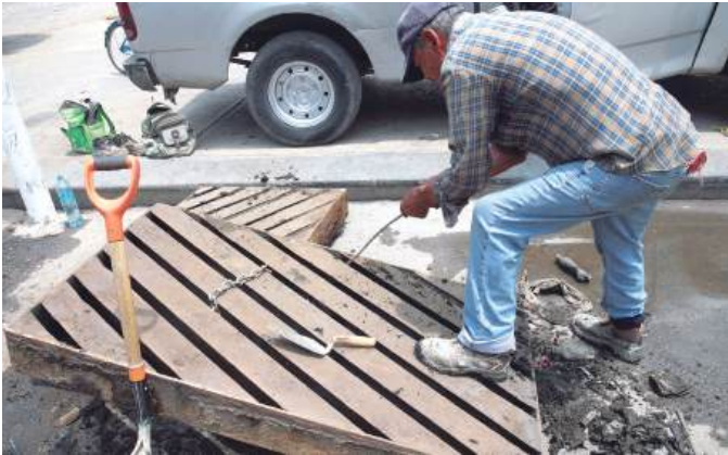
A través del Área Operativa de Desarrollo Urbano, se realizaron trabajos de limpieza, fabricación e instalación de rejillas dañadas en diversos puntos.
