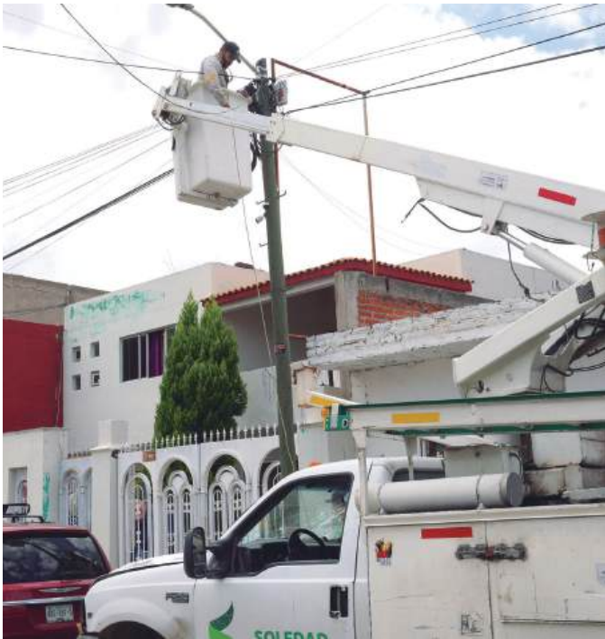
El departamento de Alumbrado Público reparó 5,340 luminarias y 237 circuitos eléctricos en todo el municipio.
