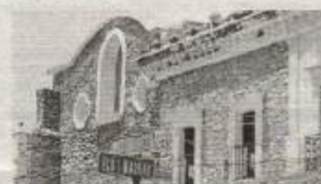
Imagen 32. Detalle en piedra, parte posterior de la Iglesia San Juan Bautista. Zona centro. Autor.
