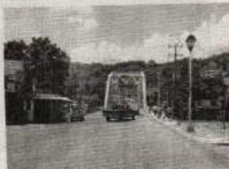
Imagen 24. Acceso al Puente Metálico Tamazunchale. El cruza la Carretera Federal No. 85 y el Río Mochizuma. Consultor.
