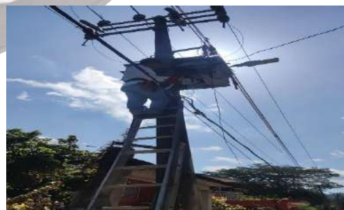
Revisó un transformador en el barrio San José, ya que un pájaro ocasiono un corto circuito, en coordinación con protección civil nos aseguramos que no ocasiono algún accidente.
