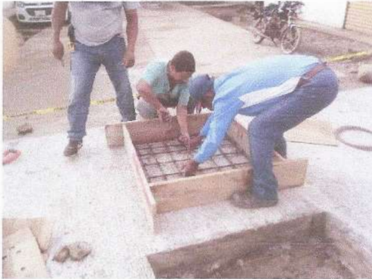
SE LE COLOCO ALAMBRE Y VARILLA
