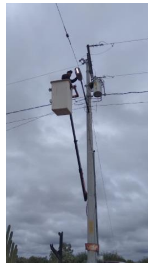
Fotografía que ilustra los trabajos en alumbrado público.
