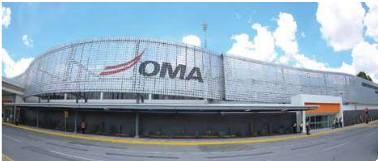
Remodelación y ampliación del Aeropuerto Internacional de San Luis Potosí.
