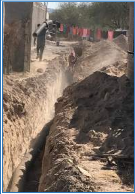
Suministro y Colocación de 95.08 Metros lineales de tubería Corrugado de 8"
