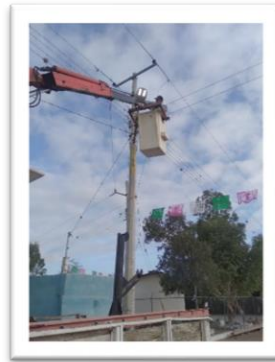
Ilustración 1 Trabajos en alumbrado público
