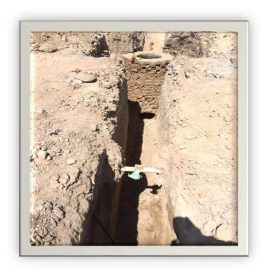
El 14 de mayo de 2020 se comenzó la instalación de línea de distribución de agua potable y drenaje sanitario en la segunda privada 5 de mayo con la aportación e instalación de 6 tramos de 2 pulgadas de diámetro
