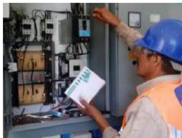
Medición de corriente y tensión de alimentación a tableros de arranque.
