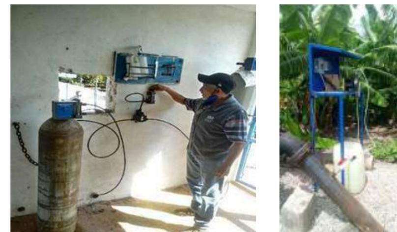
ADQUISICIÓN, INSTALACIÓN Y REPARACIÓN DE EQUIPOS DE CLORACIÓN EN TODA LA ZONA DE POZOS.
