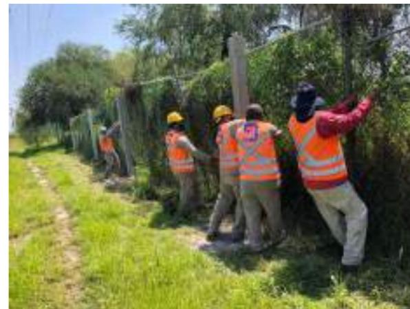
Reparaciones puntuales en cercado perimetral dañados por efectos de derrumbe de árboles en temporada de lluvias.
