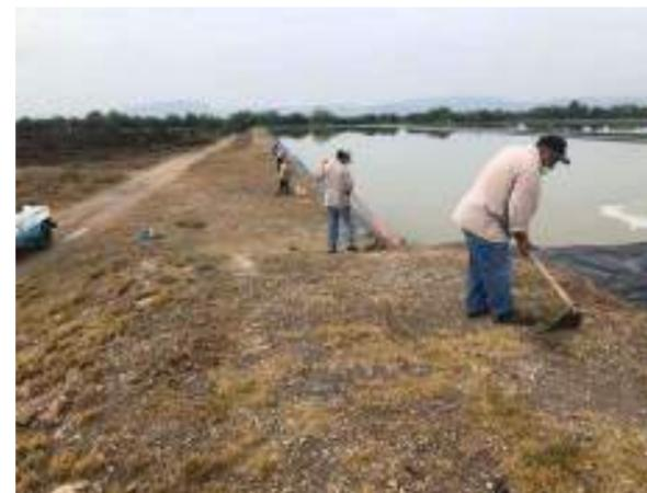
Se realizaron labores de relleno de deslaves, conformación de material y conservación de especies vegetales en taludes de las lagunas de oxidación.
