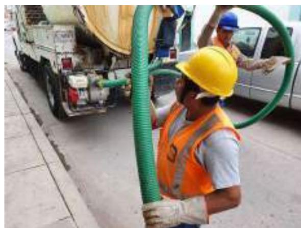
Estos desazolves permiten el correcto funcionamiento de las líneas de drenaje evitando así los estancamientos de aguas negras que por consiguiente brotarían al nivel de terreno de pavimentos o terreno natural.
