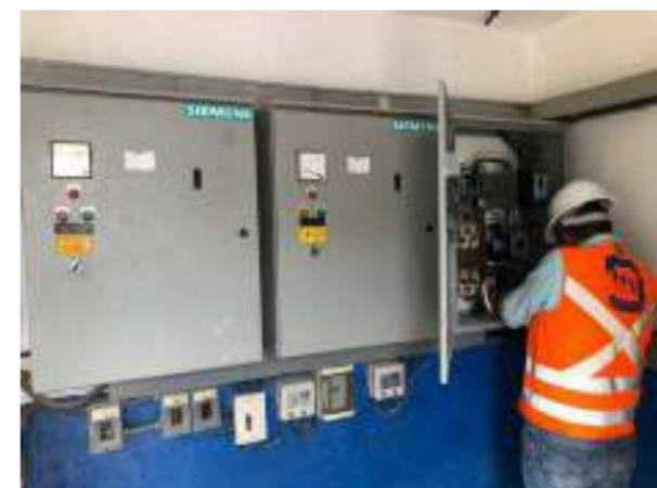
Como parte de las labores de mantenimiento en los tableros de arranque, periódicamente se realizó la sustitución de elementos eléctricos dañadas o sobrecalentadas.
