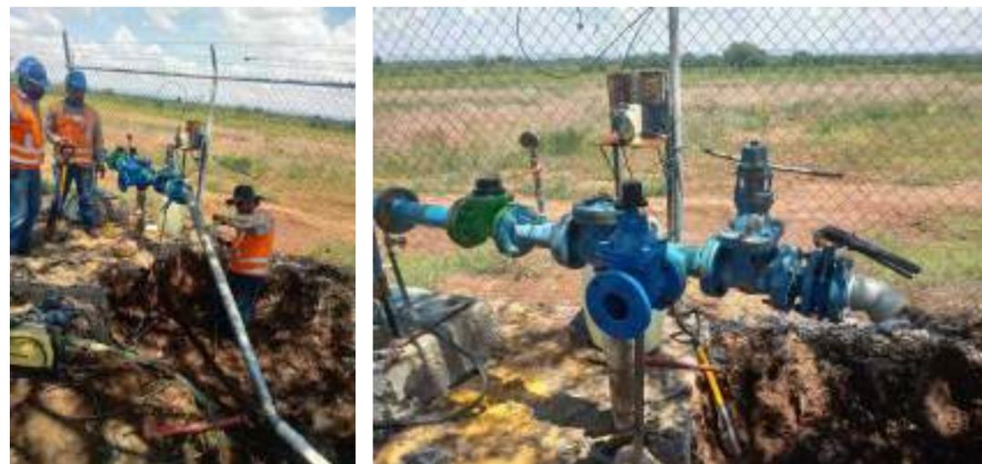
CAMBIO Y REPARACIONES DE TUBERÍA, MATERIALES EN COLUMNAS Y TRENES DE DESCARGA EN POZOS DE COMUNIDADES.
