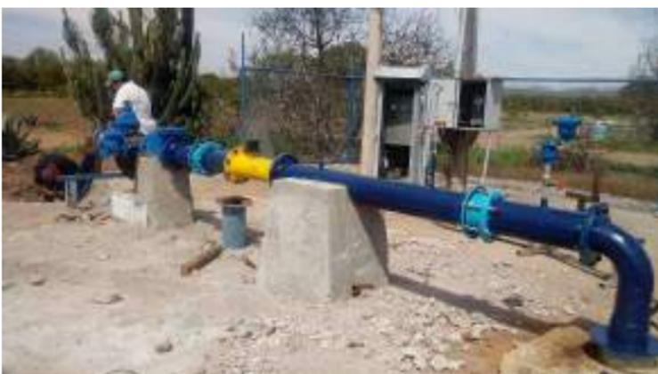
INSTALACIÓN DE TRENES DE DESCARGA EN LOS POZOS DE LA CABECERA COMPLETOS INCLUYENDO ADAPTACIÓN A LA LÍNEA DE CONDUCCIÓN.
