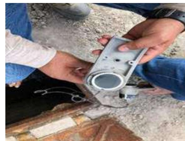
Inspección, limpieza y lubricación de sensores del Macro medidor Ultrasónico de flujo ubicados en el afluente e influente de la PTAR.
