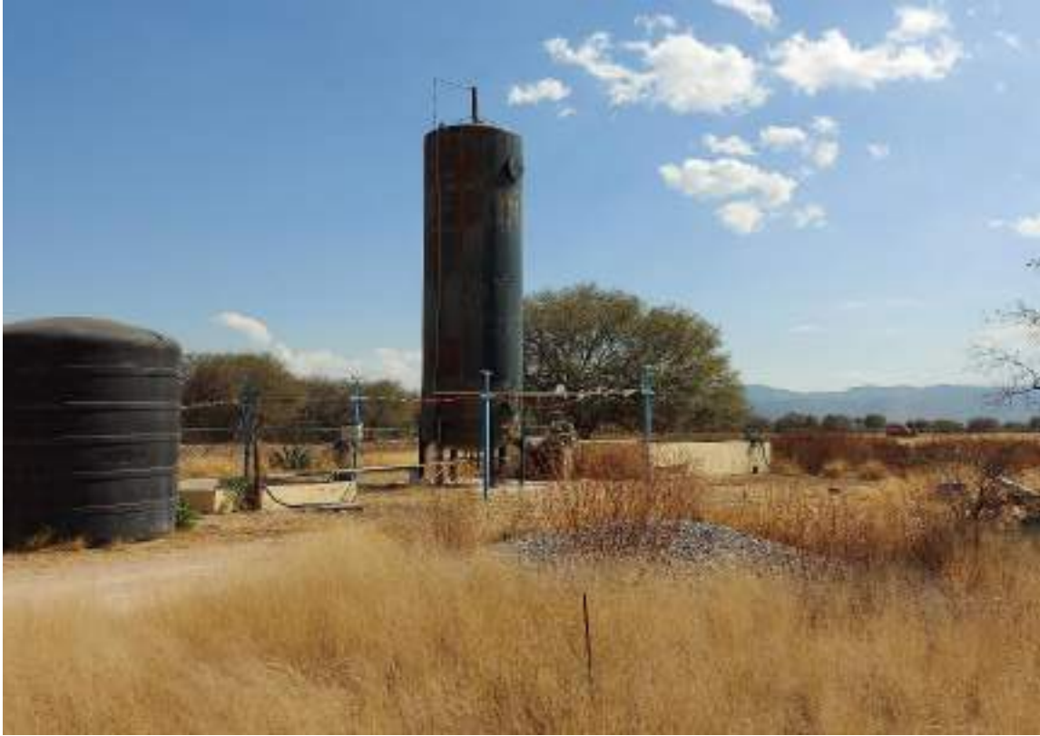
Fotografía 2 Vista general de la Planta de Tratamiento de Agua Residual.
