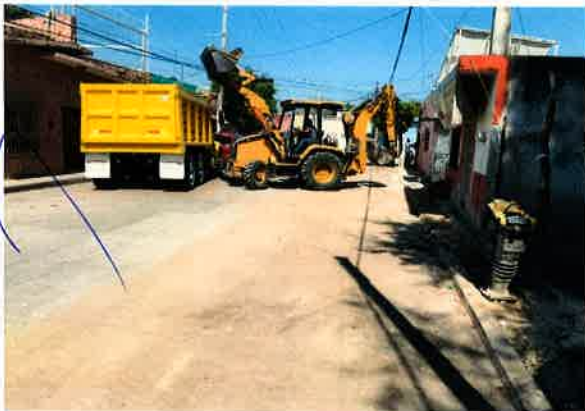
CARGA A CAMION DE MATERIAL PRODUCTO DE DEMOLICION.
