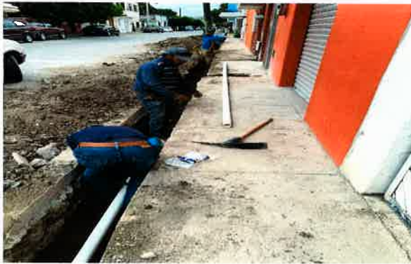
SUMINISTRO, INSTALACION Y PRUEBA DE TUBERIA HIDRAULICA DE PVC TUBO HID. ANG RD/26 DE 2" DE DIAMETRO
