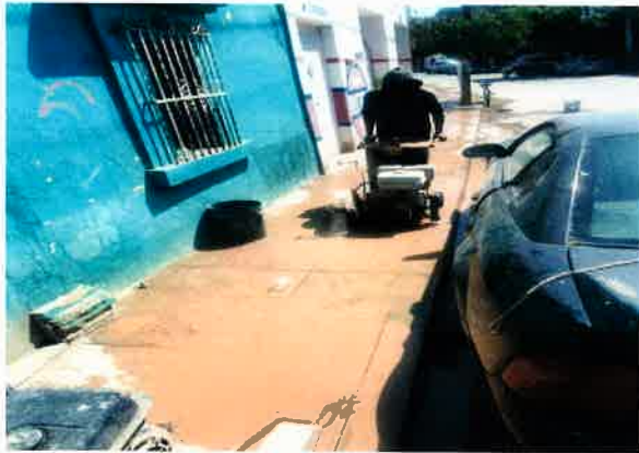
TRAZO Y CORTE C/CORTADORA DE DISCO EN PAVIMENTO DE CONCRETO HIDRAULICO.
