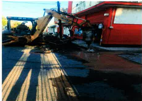
RUPTURA Y DEMOLICION DE PAVIMENTO HIDRAULICO.
