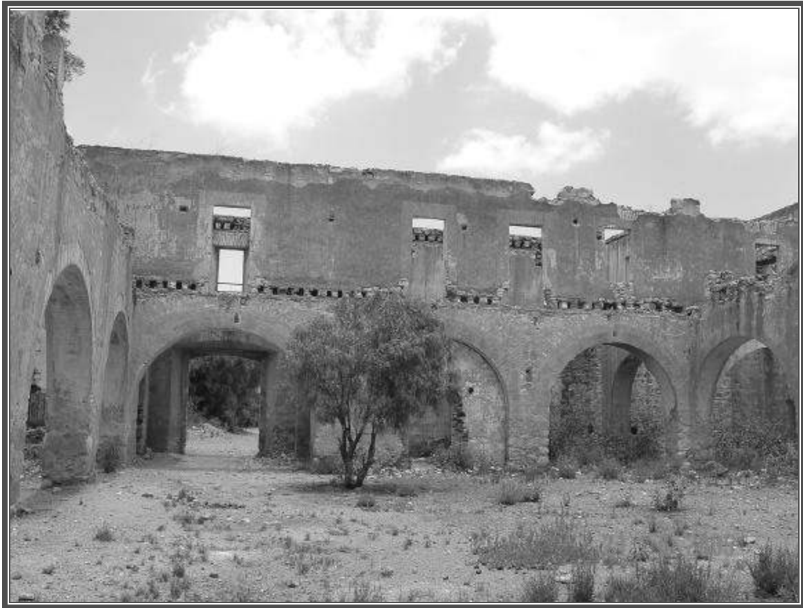
Fotografía No.80 Instalaciones mineras del Socavón del Refugio, en la comunidad de La Luz
