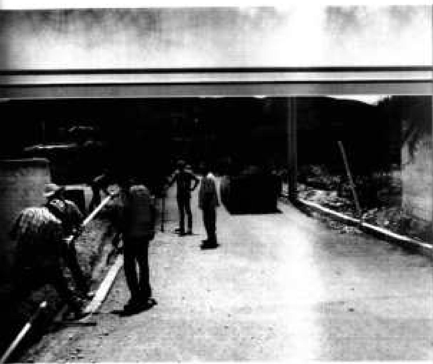
De igual manera, en la colonia Buenos Aires se rehabilitó la red de distribución de agua con tubería la calle de Lázaro Cárdenas, pues existían fugas constantemente, esto benefició a 26 usuarios del servicio, con una meta de 1000 metros lineales de tubería y una inversión de \$485,902.17 del Fondo de Infraestructura Social Municipal.
