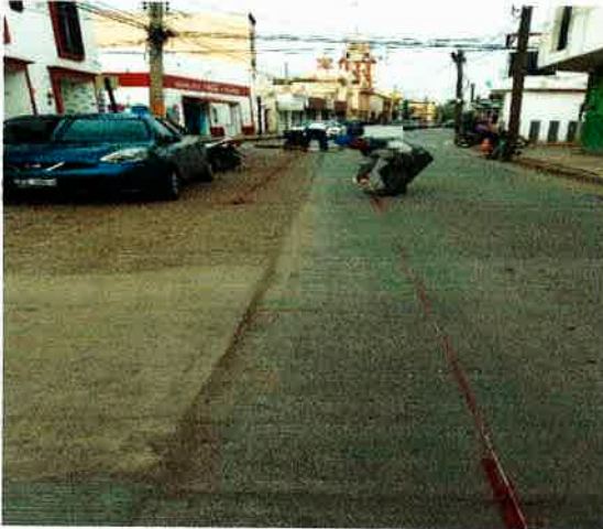
RUPTURA Y DEMOLICIÓN DE PAVIMENTO HIDRÁULICO.
