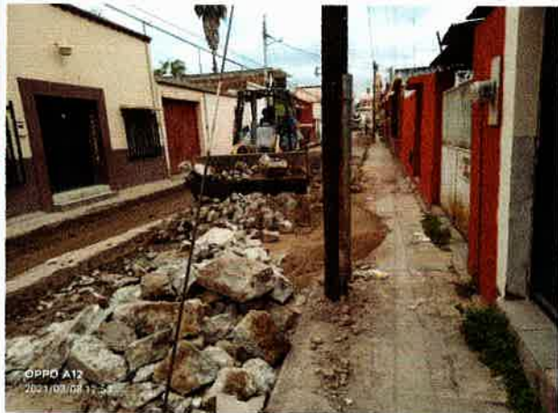
ACARREO 1ER KM DE MATERIAL PRODUCTO DE DEMOLICIÓN DE PAVIMENTO EN CAMIÓN DE VOLTEO, DESCARGA A VOLTEO EN CAMINO ZONA URBANA, TRÁNSITO NORMAL, INCLUYE CARGA.
