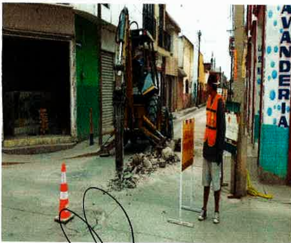
RUPTURA Y DEMOLICIÓN DE PAVIMENTO HIDRÁULICO.
