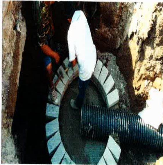
SUMINISTRO E INSTALACIÓN DE BROCALES DE PEAD PARA POZOS DE VISITA CON REJILLA ABIERTA.
