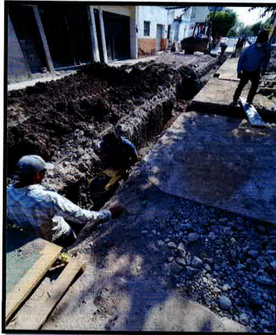
RELLENO EN ZANJAS COMPACTADO AL 90% PROCTOR, CON MATERIAL PRODUCTO DE EXCAVACION
