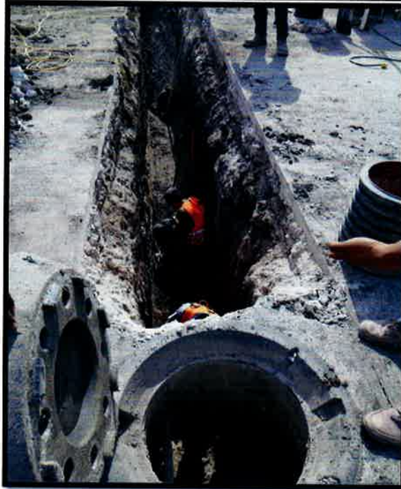
RECONEXION A LINEA CENTRAL DE DRENAJE EXISTENTE, INCLUYE MATERIAL, MANO DE OBRA Y TODO LO NECESARIO PARA SU CORRECTA EJECUCION.
