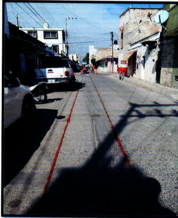
TRAZO Y NIVELACION DE LINEA DE DRENAJE ESTABLECIENDO REFERENCIAS
