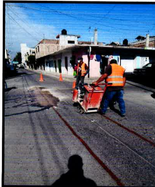
TRAZO Y CORTE C/CORTADORA DE DISCO EN PAVIMENTO DE CONCRETO HIDRAULICO.
