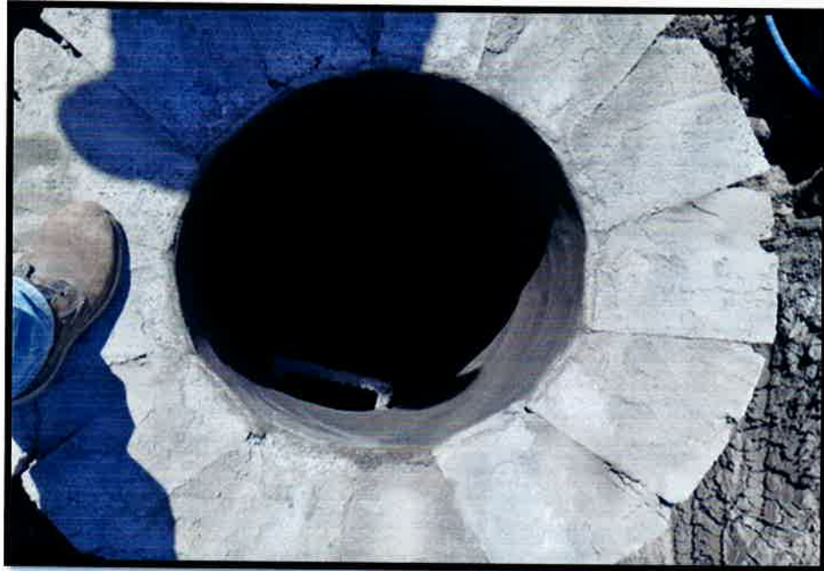
POZOS DE VISITA TIPO "COMUN", HASTA 2.50 M. DE PROFUNDIDAD
