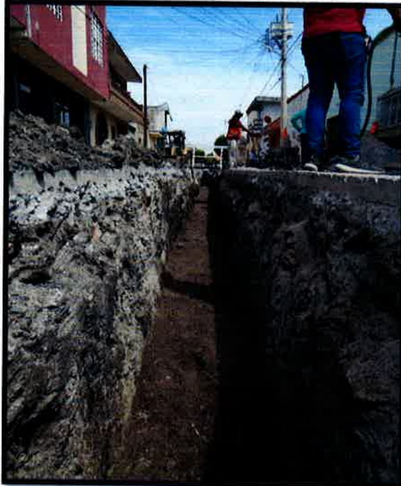
RELLENO EN ZANJAS COMPACTADO AL 85% PROCTOR, CON MATERIAL DE BANCO. (REOLITA).
