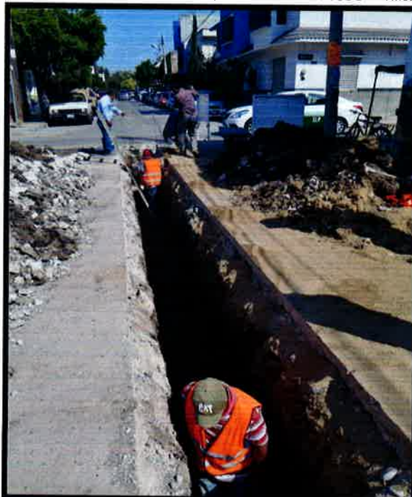
RELLENO EN ZANJAS COMPACTADO AL 85% PROCTOR, CON MATERIAL DE BANCO. (ACOSTILLADO DE ARENA).
