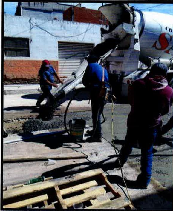
SUMINISTRO Y COLADO DE CONCRETO VIBRADO Y CURADO DE F' C=250 KG/CM2)
