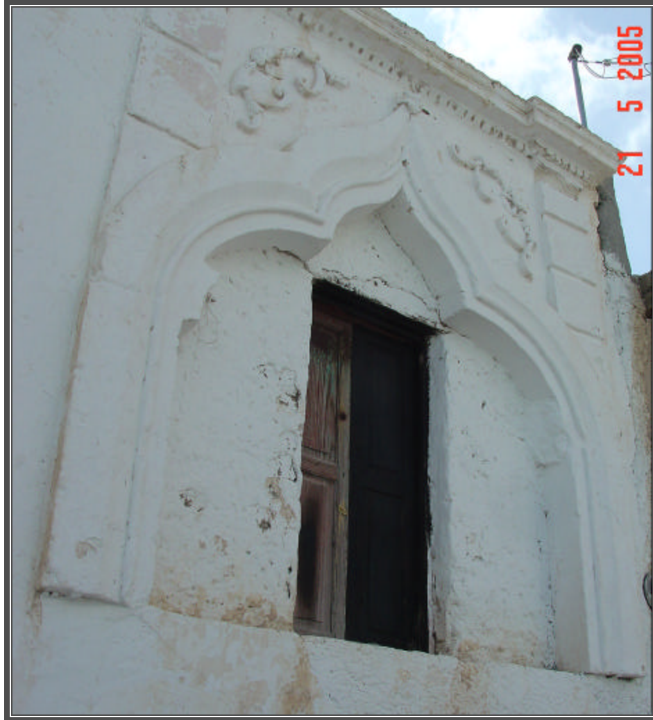
Fotografía No.16 Arquitectura vernácula en Potrero
