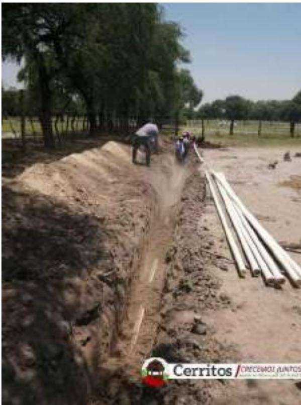
Desde una perspectiva general se realizó la ampliación de 480 metros lineales de la red de agua en la comunidad de Joya de Luna, se adquirió una válvula blindada de 2 pulgadas y una válvula globo de 2 pulgadas, permitiendo sectorizar el flujo del agua para una mejor distribución, en esta acción se invirtieron 35 mil pesos.
