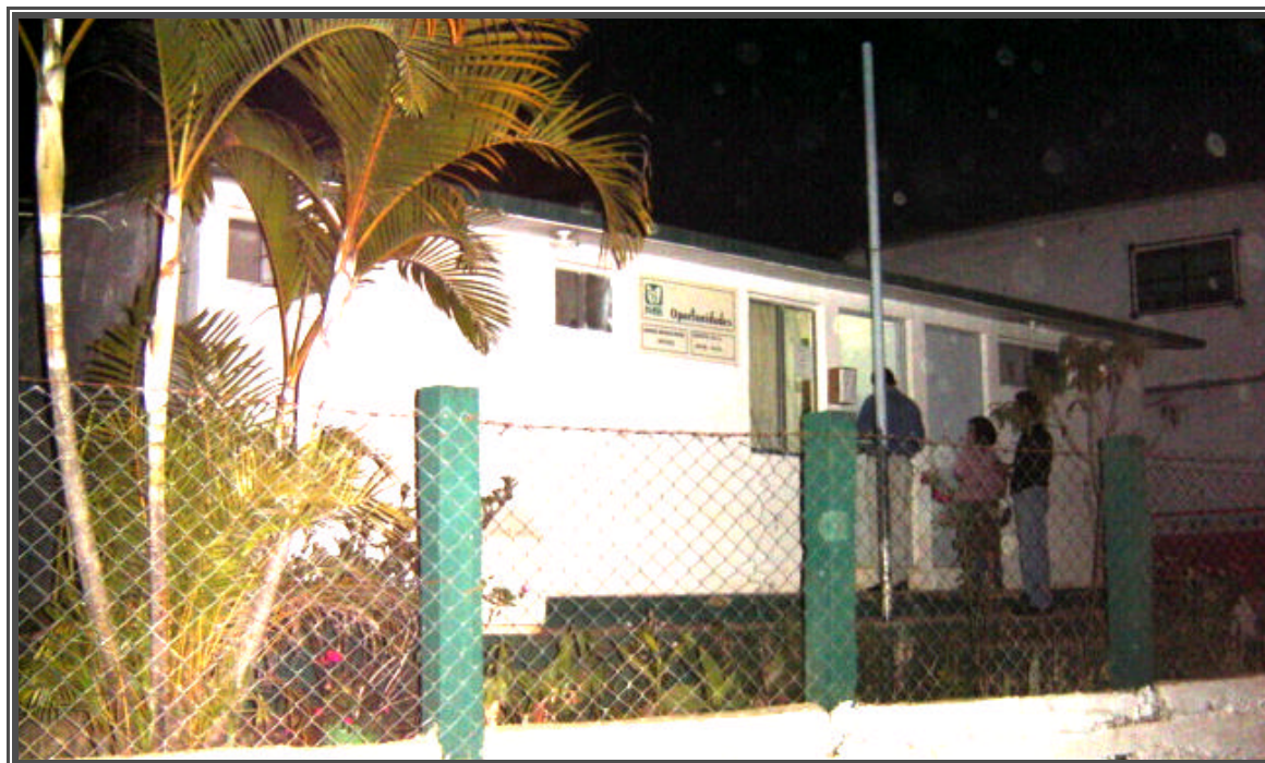
Fotografía No.20 Clínica rural en Apetzco
