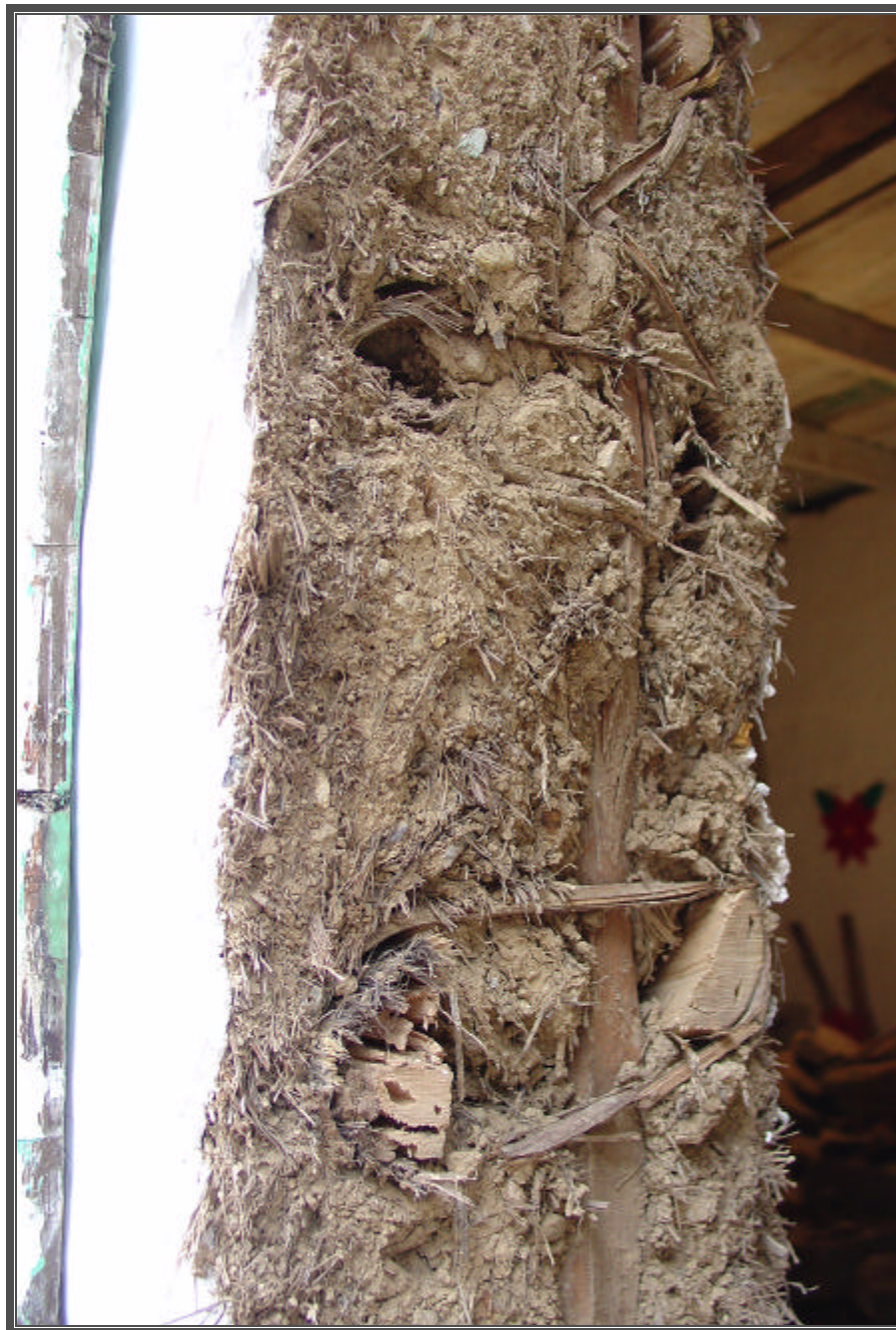
Fotografía No.26 Muro de Bajareque
