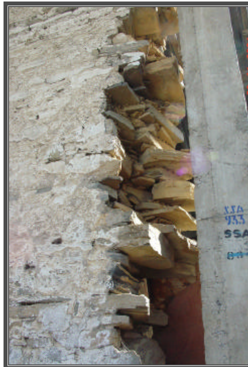
Fotografía No.29 Detalle de muro de piedra
