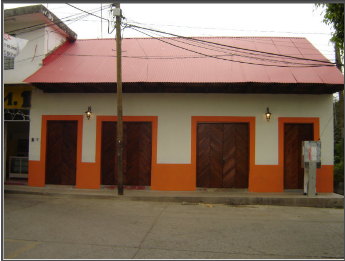
Fotografía No.54 Cableado aéreo discordante
