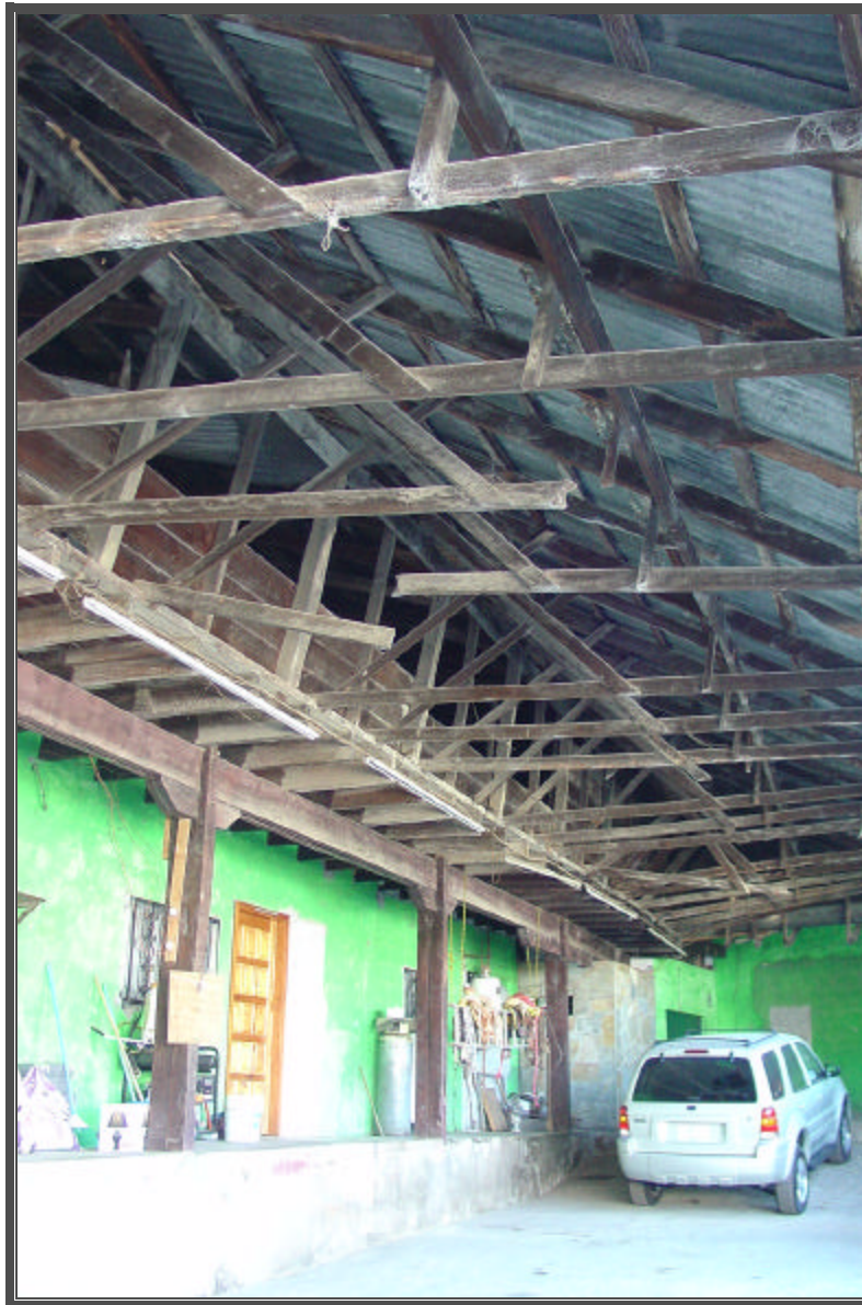
Fotografía No.12 Interior de la Instalación Cafetalera
