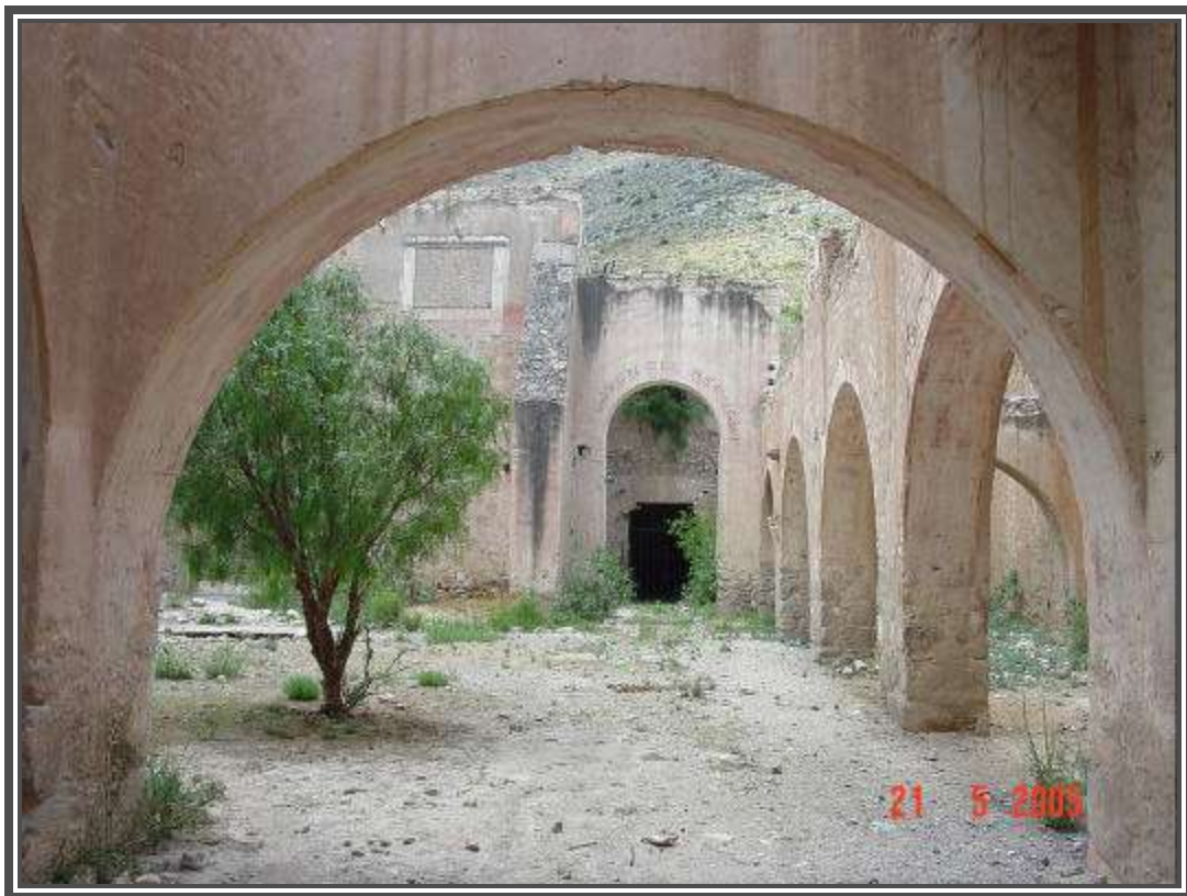
Fotografía No. 4 Socavón del Refugio
