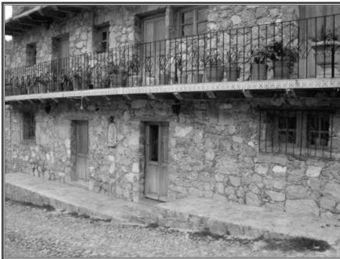
Fotografía No. 90 Materiales predominantes de construcción de la mayoría de las viviendas, piedra y adobe.
