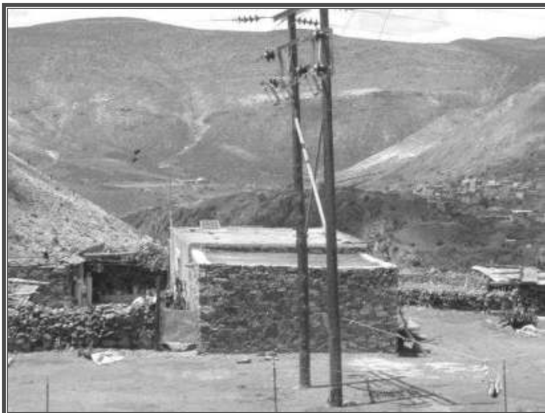
Fotografía No. 105 Veintisiete localidades cuentan con el servicio de energía eléctrica en el municipio de Catorce.
