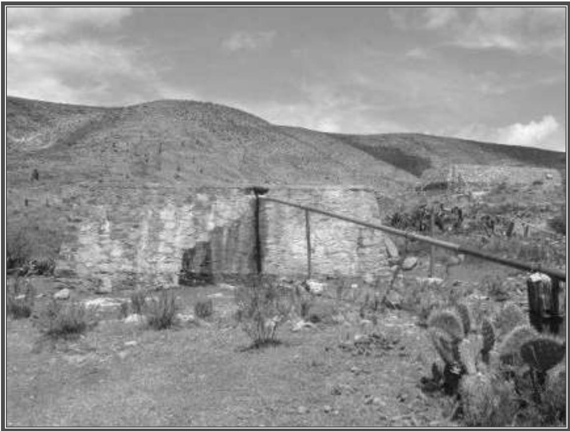
Fotografía No. 99 Infraestructura Hidráulica, almacenamiento de agua utilizados para fines domésticos.
