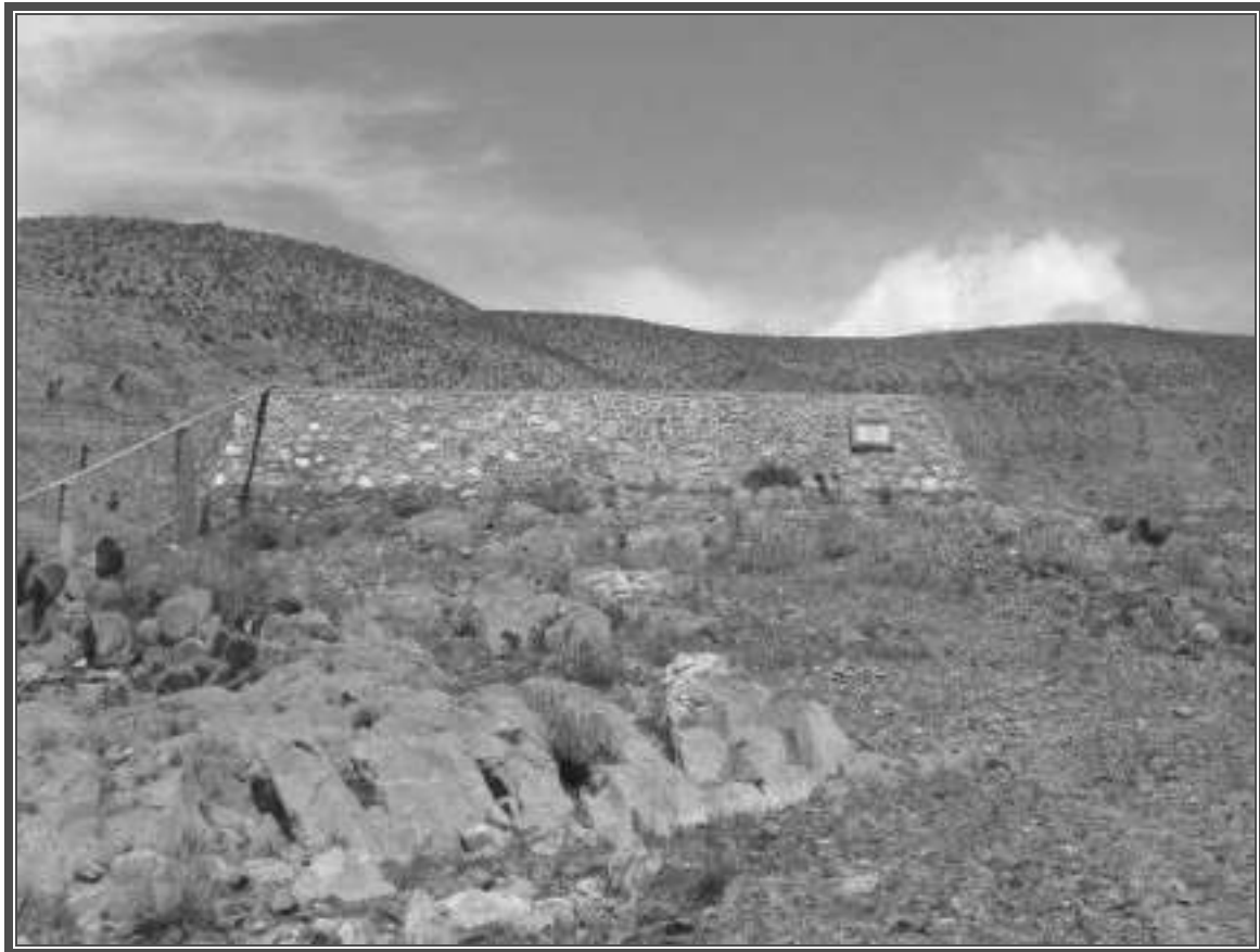
Fotografía No. 101 Depósito para el abastecimiento de agua de uso y consumo humano.
