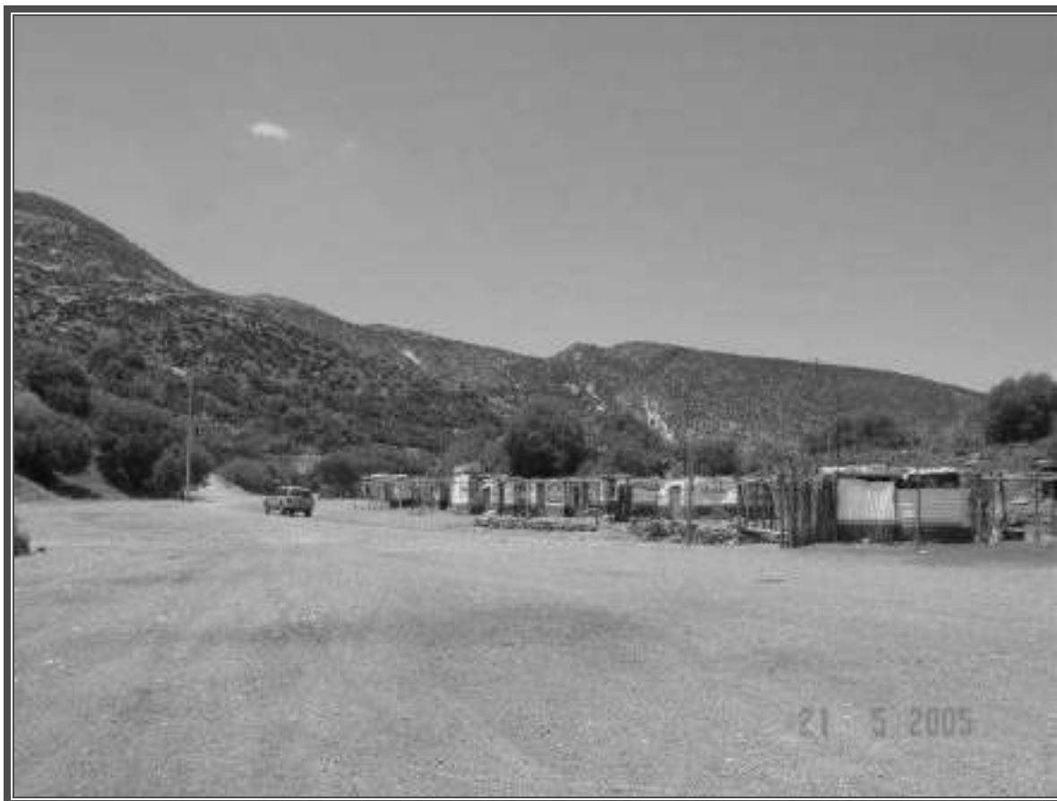
Fotografía No. 94 Carretera estatal a Real de Catorce en el tramo de La Luz
