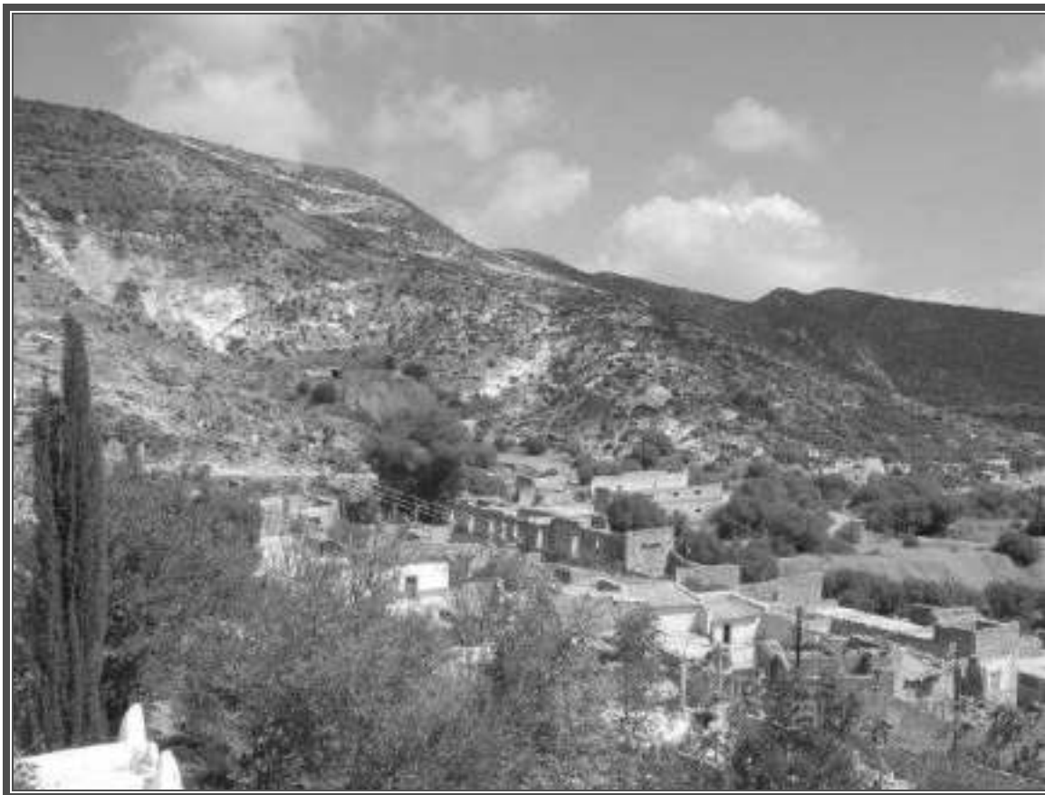
Fotografía No. 88 La Luz, presenta un reducido numero de viviendas.
