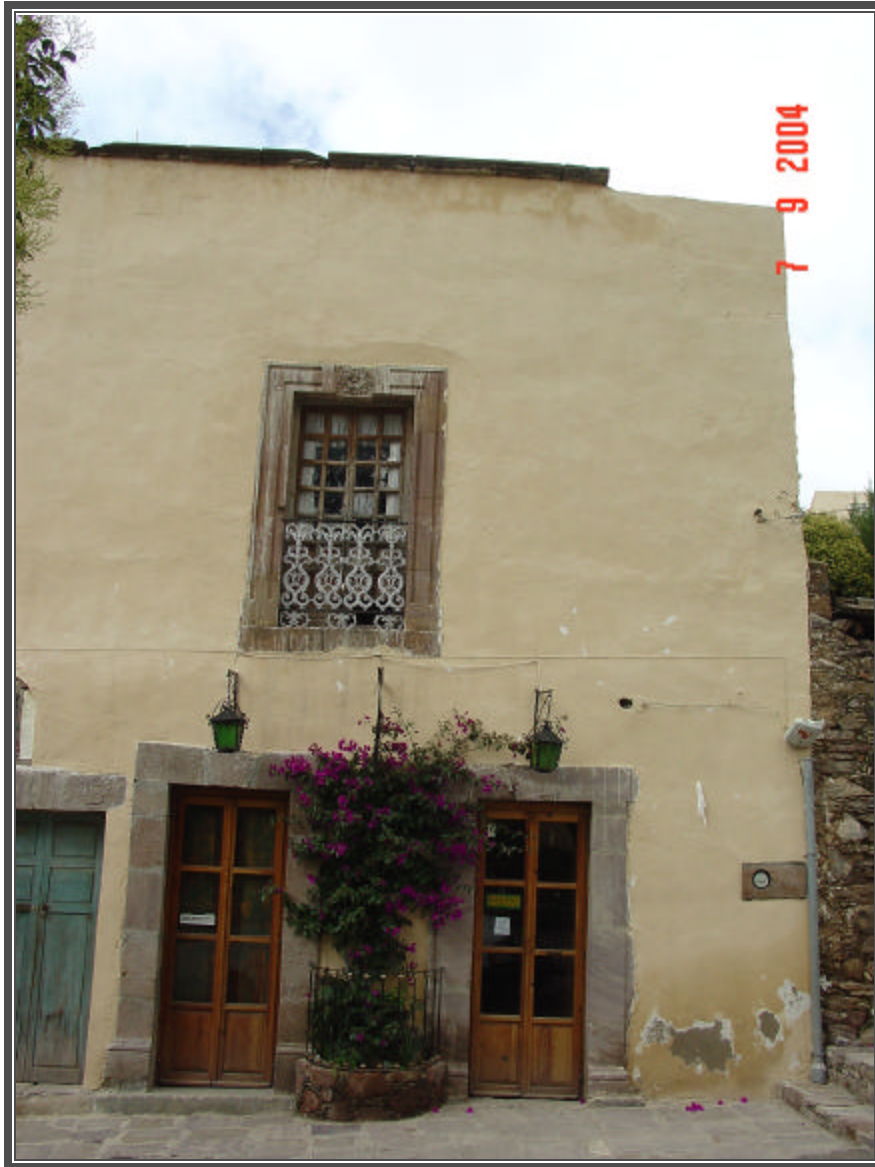
Fotografía No. 144 Vivienda mixta en Real de Catorce.
