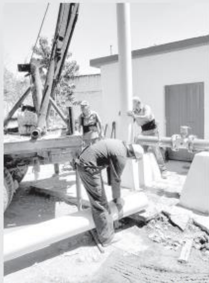
PERSONAL DE OOSAPA dio mantenimiento en pozos para mejorar el servicio en el suministro de agua.
