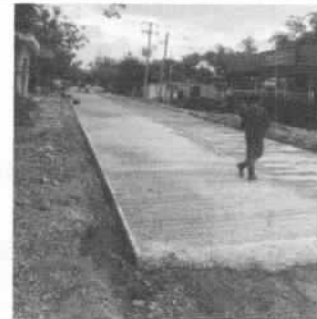
PAVIMENTACION DE CONCRETO HIDRAULICO EN CALLE MANUEL JOSE OTHON DE LA COLONIA BERMUDEZ EN CABECERA MPAL DE DISTRIBUCION DE AGUA PRIV. 3ERA
